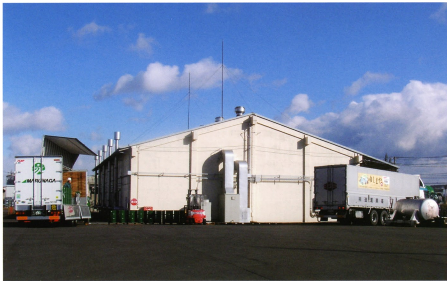
危険物105号倉庫
