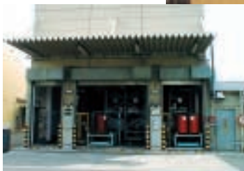
「危険物自動立体倉庫」
