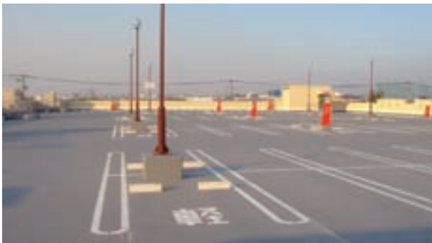
HCパークを施工したスーパーマーケットの屋上駐車場
