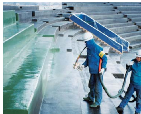
ウレタン防水材料を施工する様子
